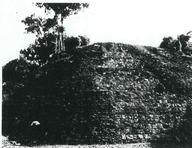
Foto 2. Edificio 144, Acrópolis Norte durante los trabajos
